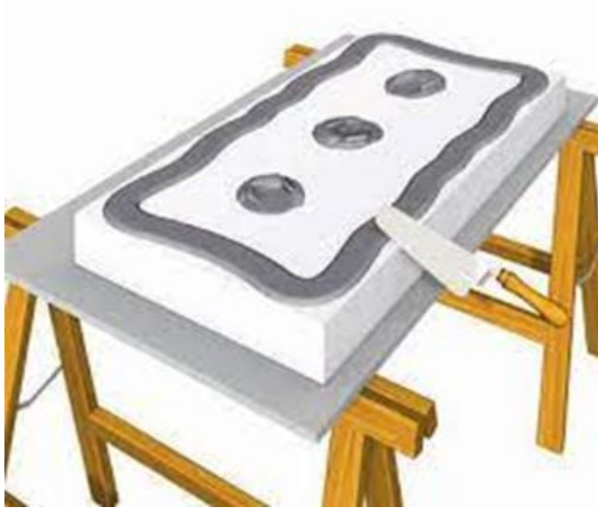
Incollaggio perimetrale e punti
