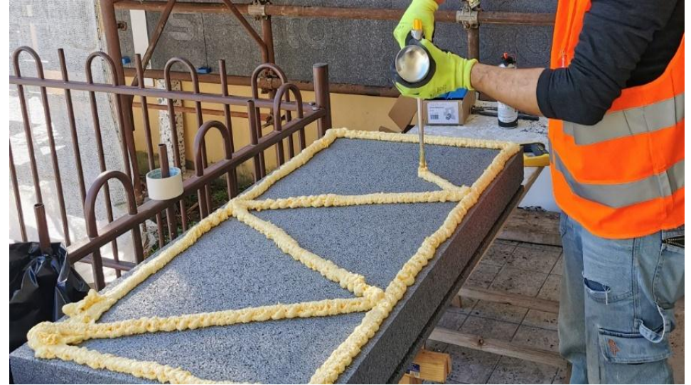
Incollaggio con adesivi poliuretanic con protezione meccanica
