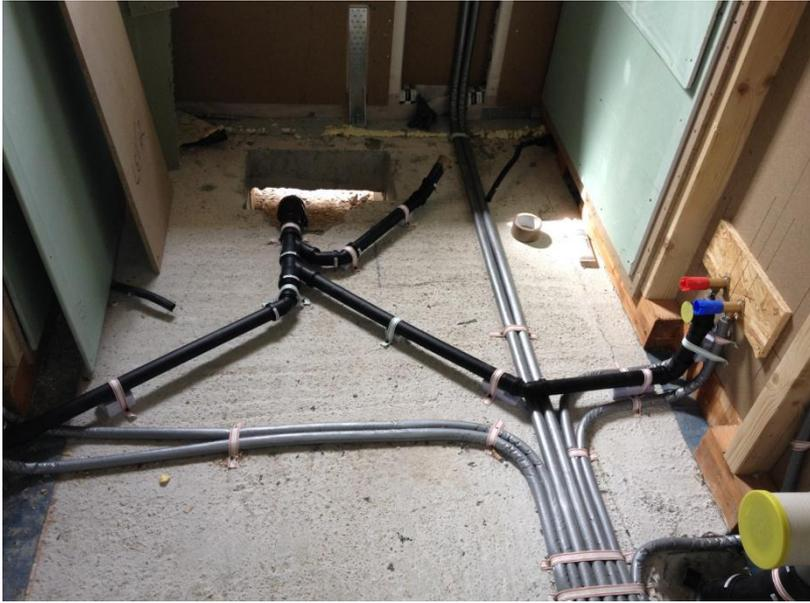
La rete idrica è di tipo duale, oltre alla normale rete di distribuzione dell'acqua potabile si è predisposta una seconda rete di distribuzione (sciacquoni e sistema di irrigazione e pulizia degli esterni) ove far circolare l'acqua raccolta in cisterna.
