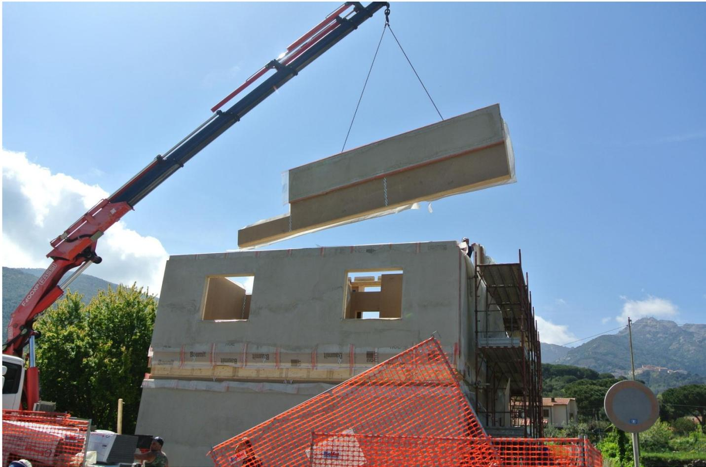
**18 Aprile 2015: montaggio struttura copertura falda nord**
