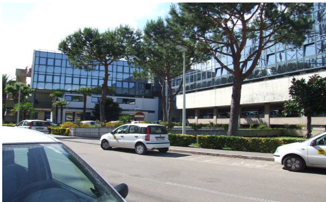
Sede dei Servizi Tecnici di Napoletanagas in Via B. Brin in Napoli
